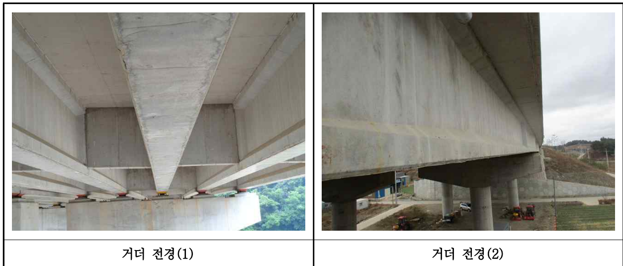
【사진 25.3.27】 거더 전경
