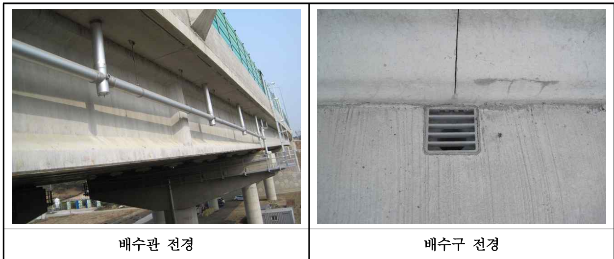
【사진 25.3.44】 배수시설 전경
