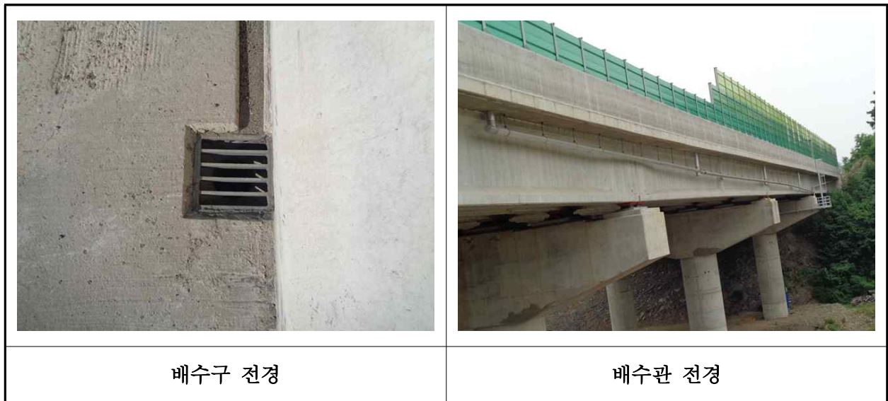
【사진 25.3.21】 배수시설 전경
