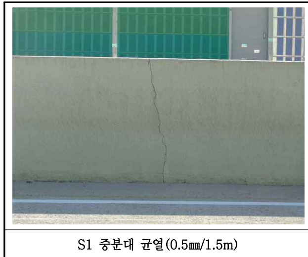
【사진 25.3.24】 방호벽 및 중앙분리대 외관조사 결과
