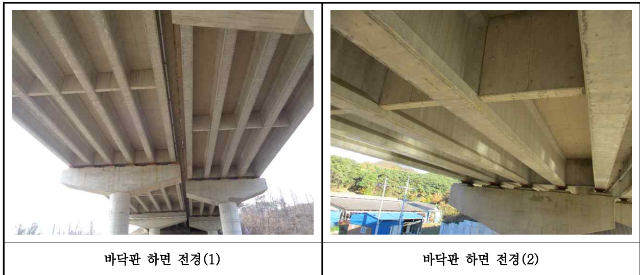
【사진 25.3.2】 바닥판하면 전경
