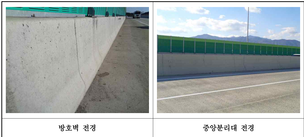
【사진 25.3.23】 방호벽 및 중앙분리대 전경
