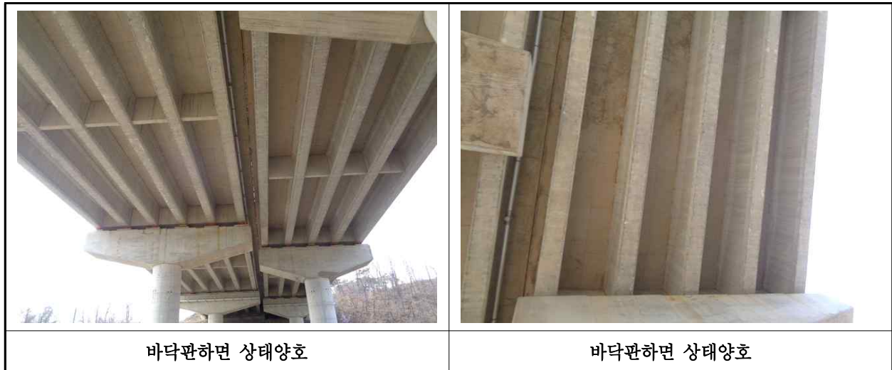
【사진 25.3.3】 바닥판하면 손상현황
