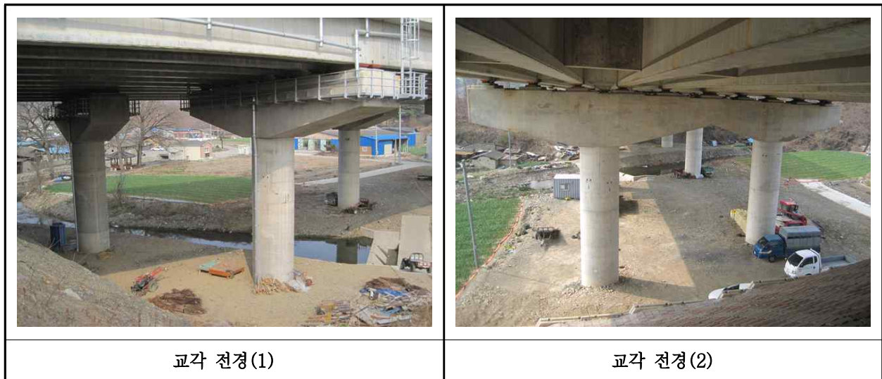
【사진 25.3.33】 교각 전경
