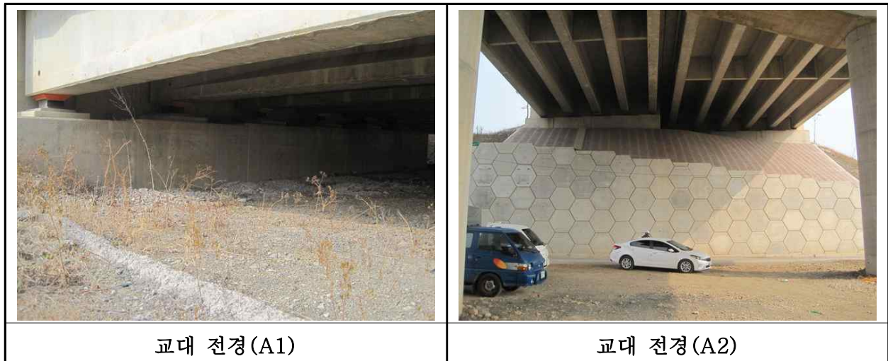
【사진 25.3.31】 교대 전경
