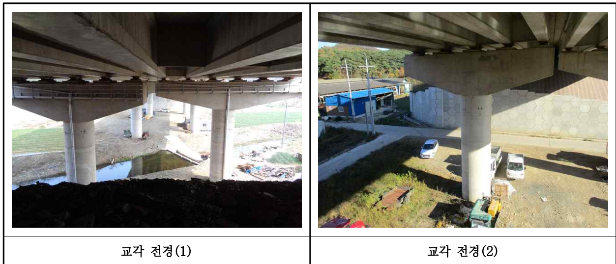
【사진 25.3.10】 교각 전경
