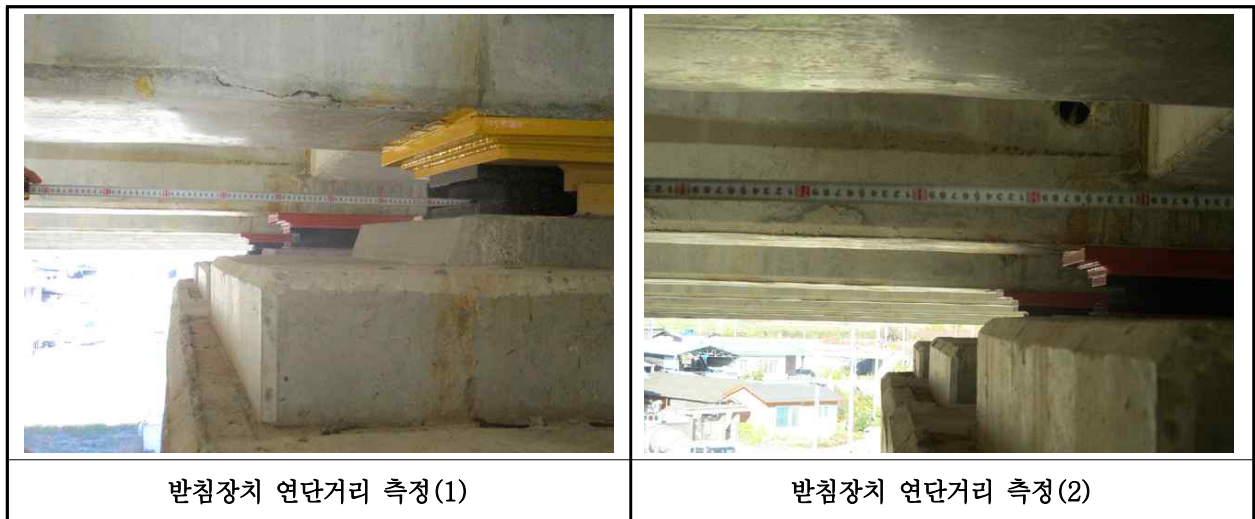
【사진 25.3.37】 교량받침장치 연단거리측정
