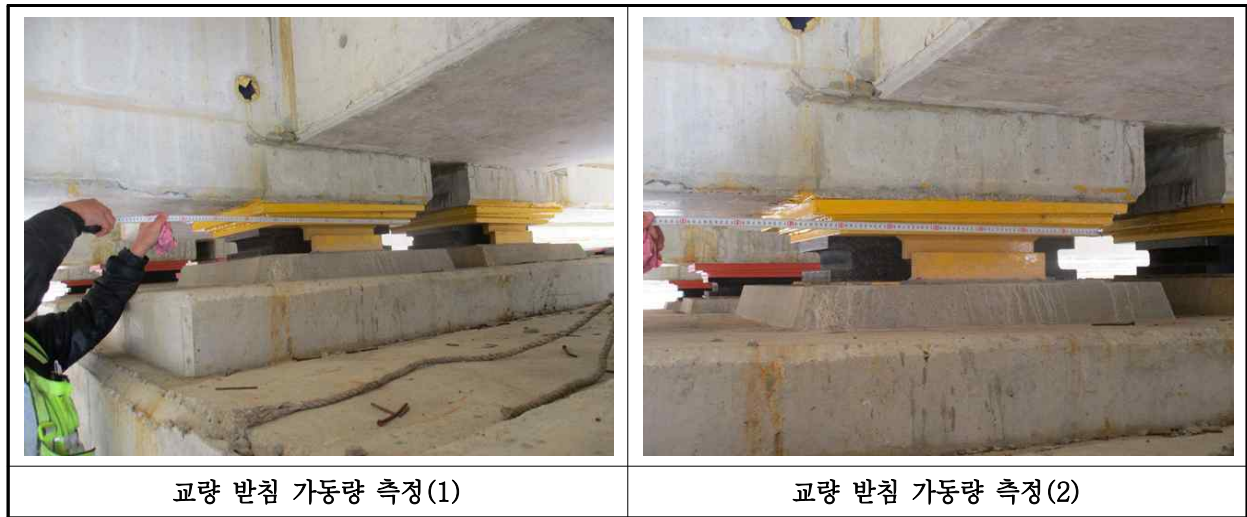
【사진 25.3.15】 교량받침 이동량 측정
