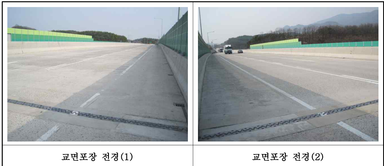
【사진 25.3.42】 교면포장 전경
