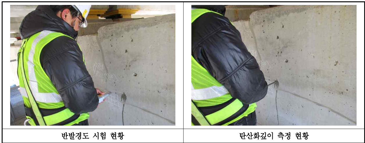
【사진 25.4.1】 콘크리트 내구성조사 현황
