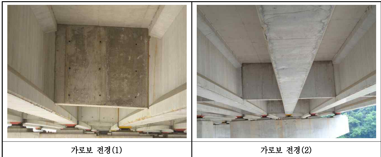
【사진 25.3.29】 가로보 전경
