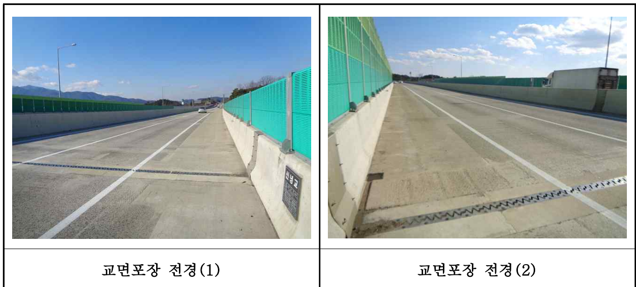
【사진 25.3.19】 교면포장 전경
