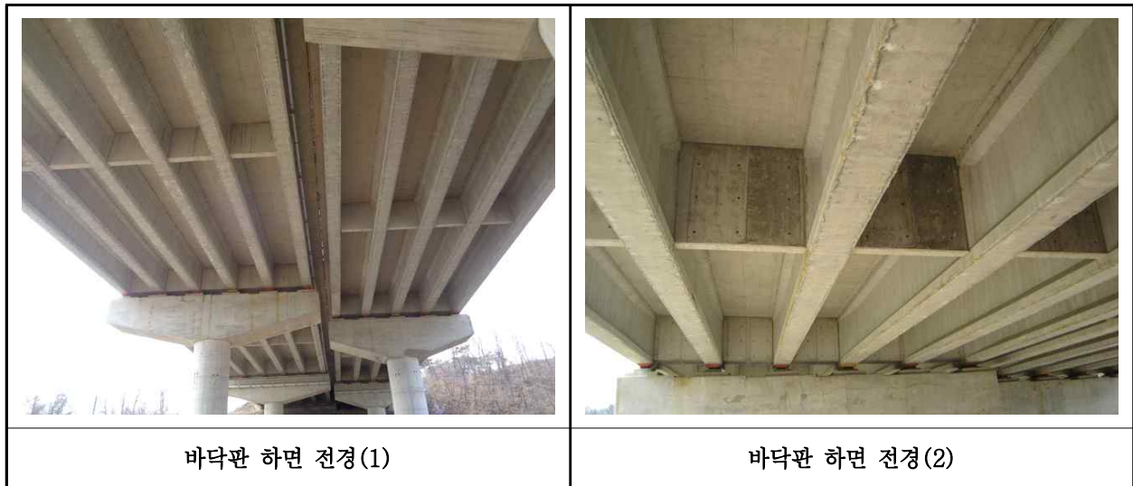
【사진 25.3.25】 바닥판하면 전경
