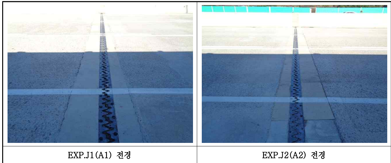
【사진 25.3.39】 신축이음장치 전경
