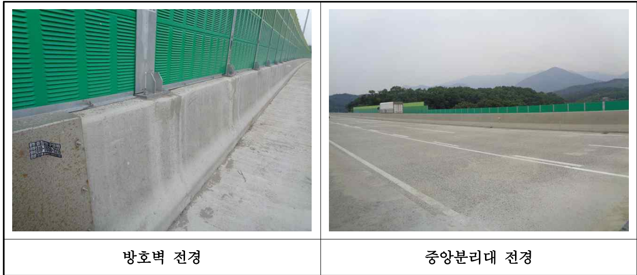
【사진 25.3.46】 방호벽 및 중앙분리대 전경
