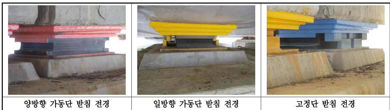
【사진 25.3.35】 교량받침 전경
